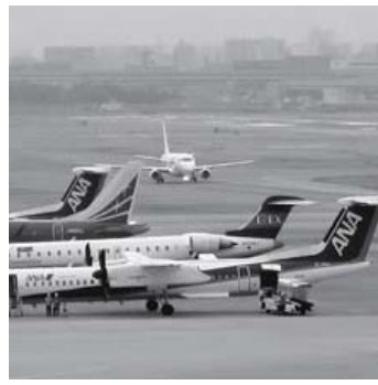
第2滑走路の増設工事が進む福岡空港
